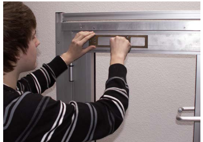
Nach Einsetzen der Gewindehülsen wird bei Bedarf die Montageplatte angebracht.
