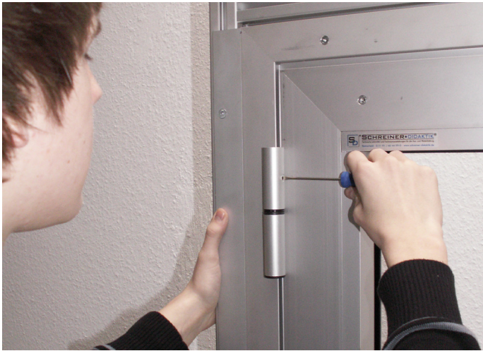
Die Tür ist mit einstellbaren Türbändern ausgestattet.
