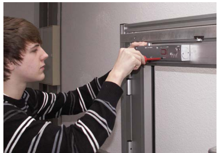
Schließgeschwindigkeit und Schließkraft können nun eingestellt werden.
