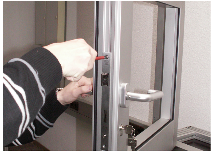
Die Drückergarnitur kann aus- und eingebaut werden...
