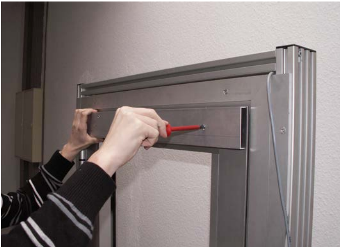
Zur Montage von unterschiedlichen Türschließern werden Montageprofile an die Tür geschraubt.
