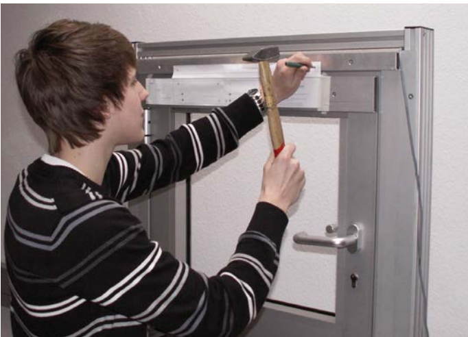
Die Position der einzusetzenden Gewindehülsen wird markiert.
